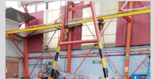
PUENTE GRUA 3 NT
